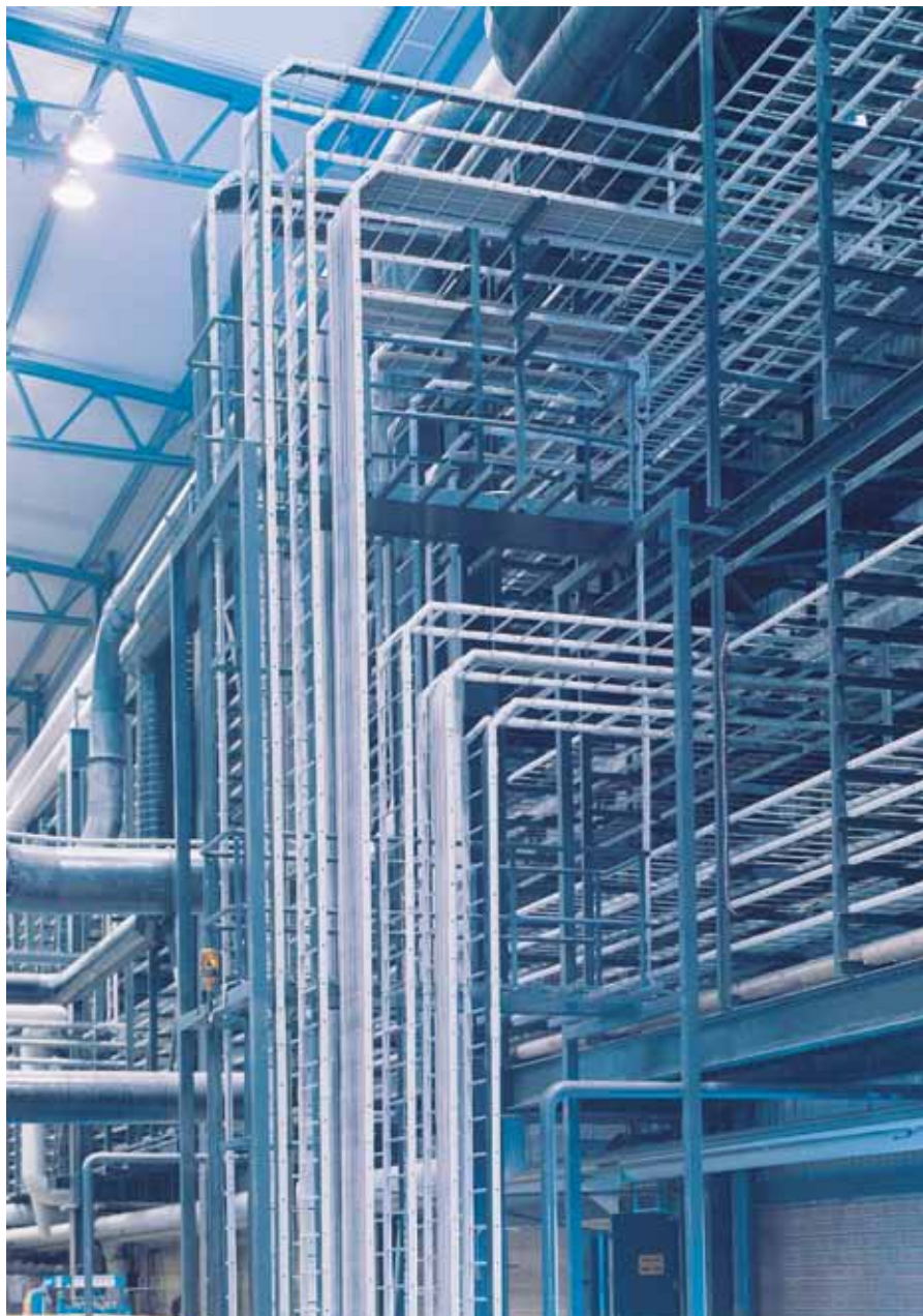
Кабельные лестницы WIBE KHZ, смонтированные на металлургическом заводе SSAB в г.Борлэнге, Швеция.
