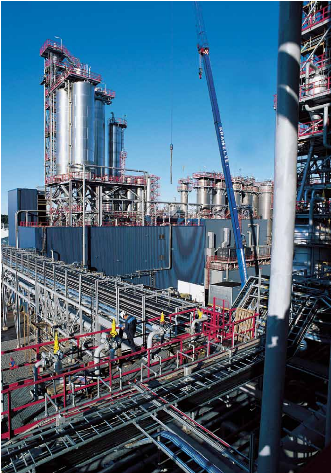
Кабельные лестницы WIBE KHZ и KHZ, смонтированные на предприятии компании Vorealis в г. Стенунгсунд, Швеция. Компания Vorealis поставляет заказчикам специальные пластмассы для крупнейших производителей электроэнергии, нефтяных и водяных трубопроводных проектов в мире.
