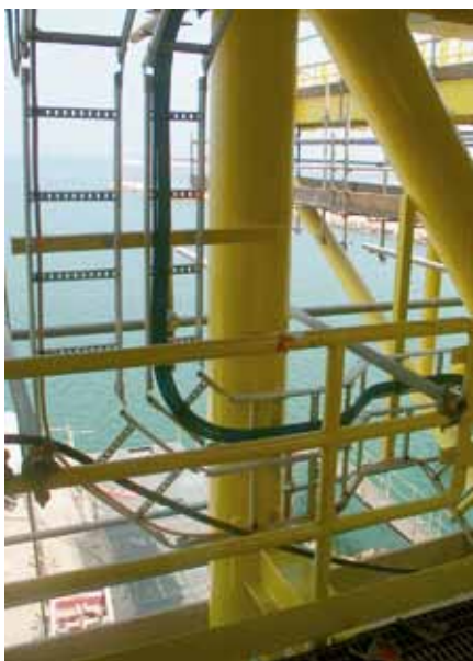
Кабельные лестницы WIBE KHZP с покрытием Zinkroх®, смонтированные на буровой платформе BP/ARCO/Technip на морском нефтяном месторождении Al Rayyan, Катар.
