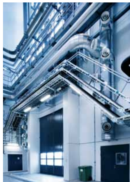
Кабельные лестницы WIBE KHZV, смонтированные на электростанции Gärdstaverken, Швеция
